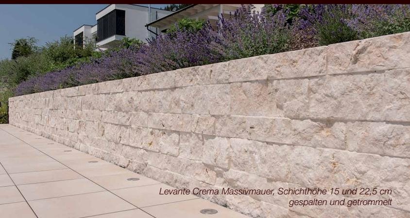
*Levante Crema Massivmauer, Schichthöhe 15 und 22,5 cm gespalten und getrommelt*
